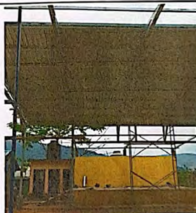
Foto 4: MEJORAMIENTO MODULO 5 (ESCENARIO), CUBIERTA DE LAMINA
