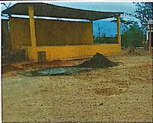
Foto 1: MEJORAMIENTO MODULO 5 (ESCENARIO), ESTRUCTURA DE TECHO
