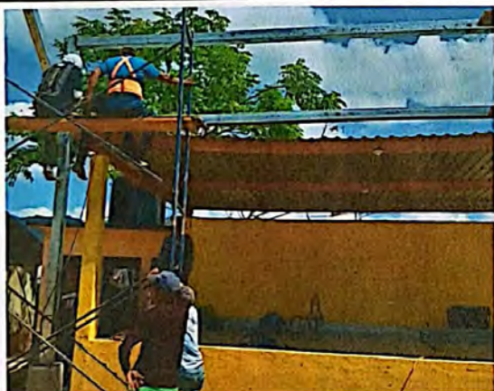
Foto 3: MEJORAMIENTO MODULO 5 (ESCENARIO), ESTRUCTURA DE TECHO
