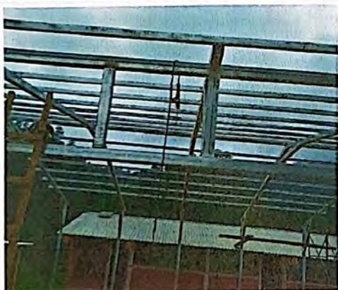
Foto 3: MEJORAMIENTO MODULO 5 (ESCENARIO), CUBIERTA DE LAMINA
