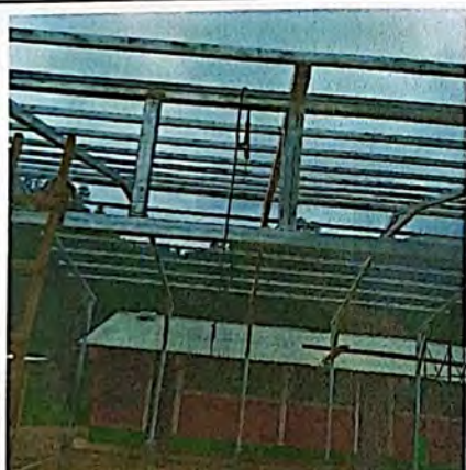
Foto 3: MEJORAMIENTO MODULO 11 (PATIO DEL ESTABLECIMIENTO), PORTICO, CUBIERTA DE LAMINA
