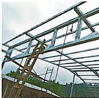
Foto 2: MEJORAMIENTO MODULO 5 (ESCENARIO), CUBIERTA DE LAMINA
