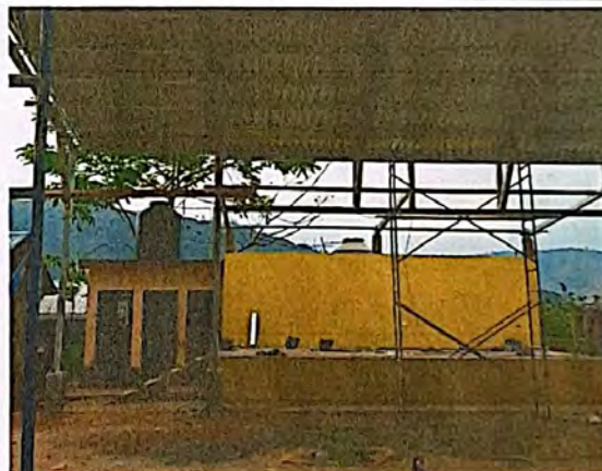
Foto 4: MEJORAMIENTO MODULO 5 (ESCENARIO), ESTRUCTURA DE TECHO
