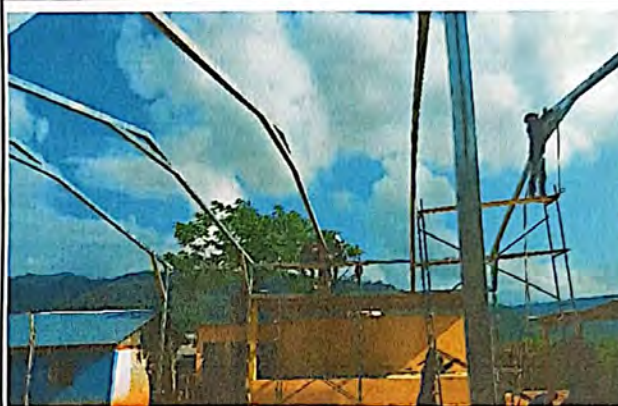
Foto 2: MEJORAMIENTO MODULO 5 (ESCENARIO), ESTRUCTURA DE TECHO
