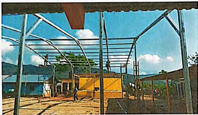
Foto 1: MEJORAMIENTO MODULO 5 (ESCENARIO), CUBIERTA DE LAMINA
